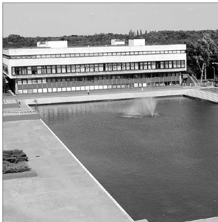
Bielany po remoncie małej architektury.
