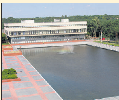
07/2008 – Bielany po remoncie małej architektury
