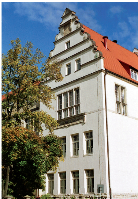
Budynek przy ul. Sienkiewicza 30/32
